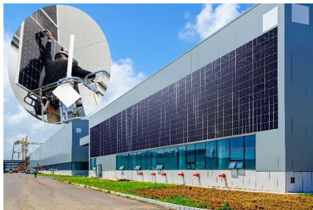
データセンターへの施工イメージ
