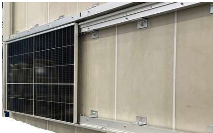
アスロックレールファスナー太陽光パネル設置工法 (AGC グループの「SUNBRICK™」を採用)
