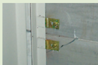
ボルト位置不良の例 (新潟県中越地震の例)
