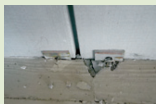
モルタルで埋め込まれた例
