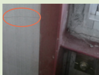
サッシ枠にモルタルを充填した例
