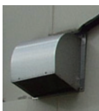
設備開口外側
