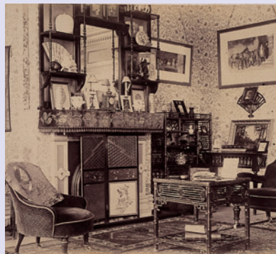
建設当時の十五番館内部 （バーガレー氏個人アルバム2、写真提供：神戸市立博物館）
