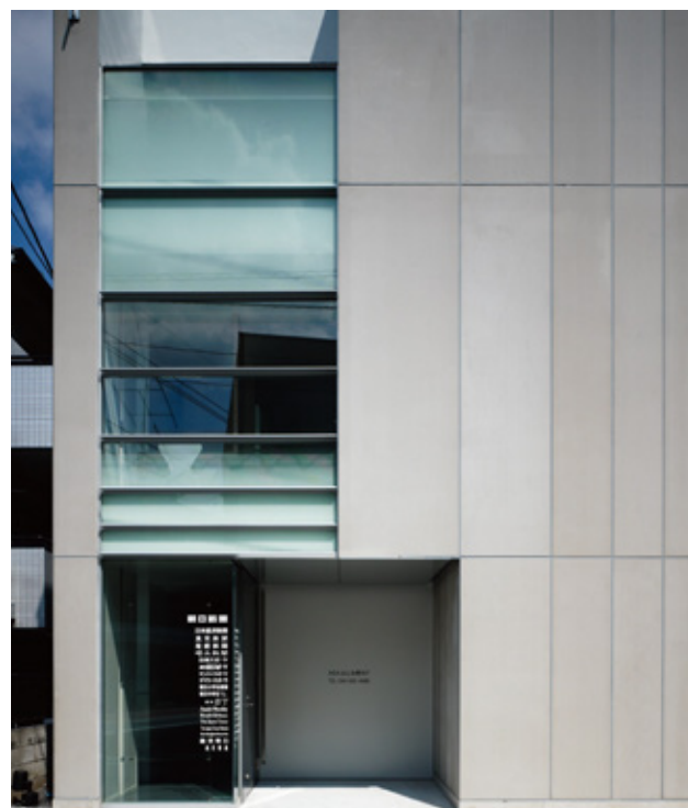
物件名 ASAふじみ野NT 所在地 埼玉県ふじみ野市 設計 ラウンドテーブル一級建築士事務所 施工 小澤建設 外壁 「アスロック600」ナチュリアル PHOTO コピスト
