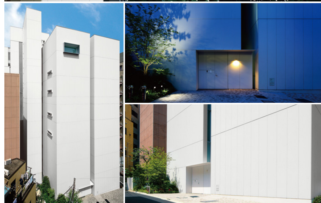
物件名 GC Corporate Center 外壁 「アスロック600」 所在地 東京都文京区 工場塗装仕上げ(ルミセラコート) 設計監督 谷口吉生(谷口建築設計研究所) 設計 KAJIMA DESIGN 施工 鹿島建設東京建築支店
