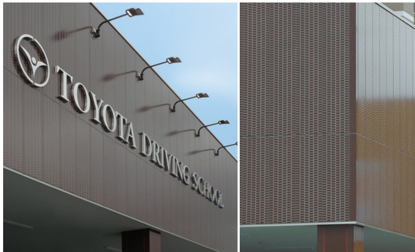
物件名 豊田自動車学校 外壁 「ランディルB」 所在地 愛知県豊田市 工場塗装仕上げ (カラーセランWコート) 設計 TIA建築研究所 「アスロック600」 施工 まるひ建設 工場塗装仕上げ (カラーフロン)
