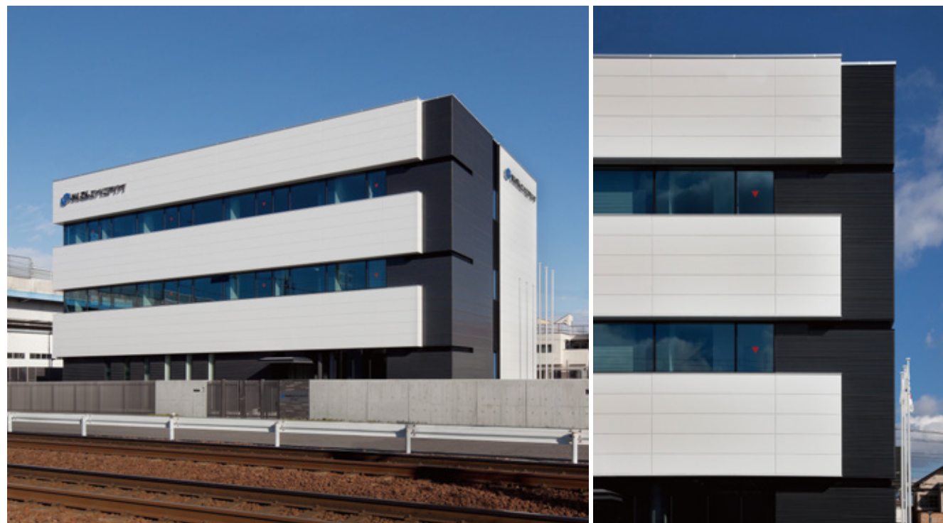
物件名 かんでんエンジニアリング豊田営業所 外壁 「アスロック500」 所在地 愛知県知立市 「タスロック500」 設計 松田平田設計 工場塗装仕上げ(ニューカラリード) 施工 トヨタT&S建設 PHOTO 黒田青巖
