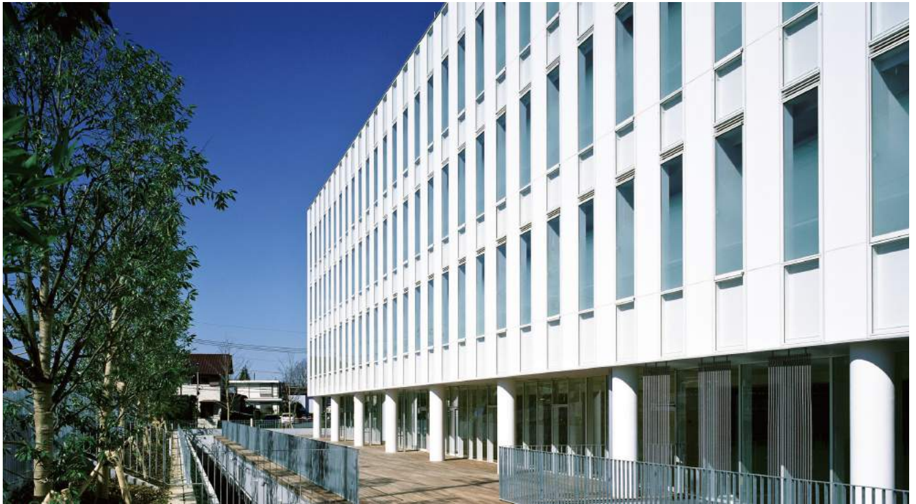
物件名 聖マリアンナ医科大学教育棟 外壁 「アスロック900」 所在地 神奈川県川崎市 現場塗装仕上げ 設計 日本設計 PHOTO エスエス東京 施工 大成建設
