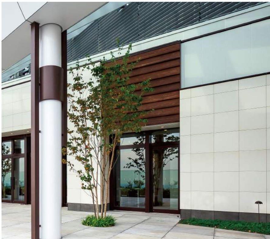
物件名 虎ノ門ヒルズ(環状第二号線新橋・虎ノ門地区第二種市街地再開発事業Ⅲ街区) 外壁 「レールファスナー工法」石張り仕上げ 所在地 東京都港区 「アスロック600」 設計 日本設計 現場塗装仕上げ、工場塗装仕上げ(カラーフロン) 施工 大林組
