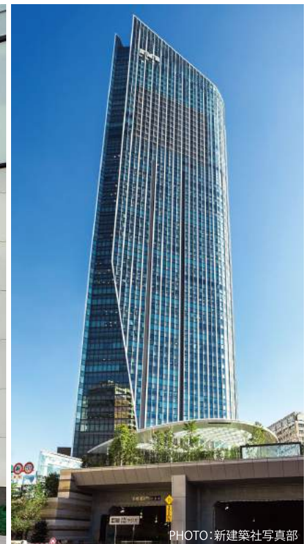
物件名 虎ノ門ヒルズ(環状第二号線新橋・虎ノ門地区第二種市街地再開発事業Ⅲ街区) 外壁 「レールファスナー工法」石張り仕上げ 所在地 東京都港区 「アスロック600」 設計 日本設計 現場塗装仕上げ、工場塗装仕上げ(カラーフロン) 施工 大林組
