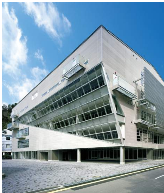
物件名 京都精華大学本館 所在地 京都市左京区 設計 鈴木隆之デザインネットワーク+ 京都精華大学鈴木研究室 施工 三井住友建設 外壁 「アスロック600」ナチュリアル
