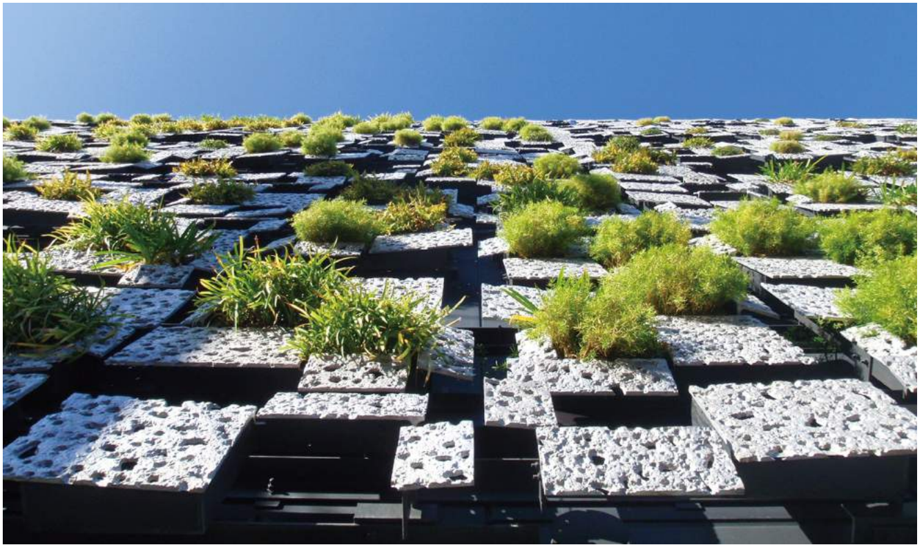
物件名 green cast 外壁 「レールファスナー工法」 所在地 神奈川県小田原市 アルミパネル+緑化仕上げ 設計 隈研吾建築都市設計事務所 施工 竹中工務店
