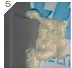
Zクリップ部の断熱補修完了。
