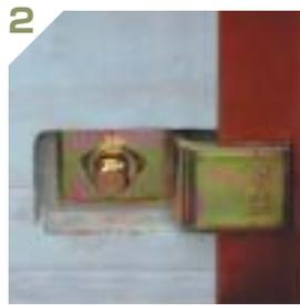
Zクリップの留付けは、断熱材をくり抜きます。
