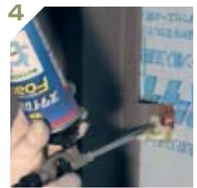
Zクリップ部の断熱補修。
